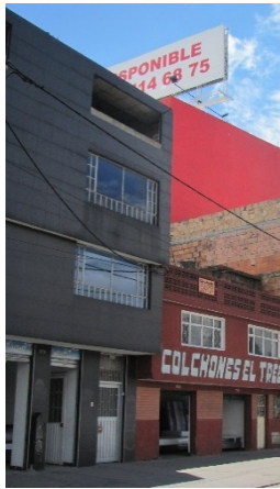
Valla instalada sin registro – Sentido Norte – Sur - Texto publicidad: Disponible Tel 4146875
